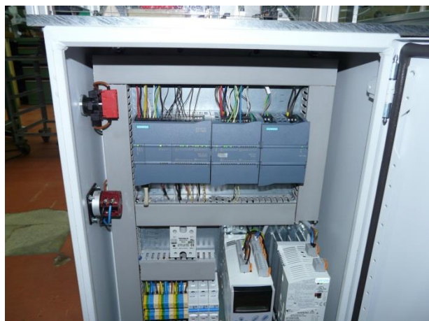
Slika 24: Sestavljeno krmilje v napravi z vsemi potrebnimi elementi (vir: avtor naloge)
